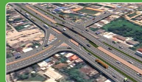
ภาพตัวอย่างของรูปแบบที่ 1 : การก่อสร้างทางยกระดับ บนแนวทางหลวงหมายเลข 331
